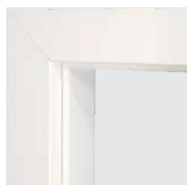
Ościeżnica bezprylgowa H/SB zacinana pod kątem 45°
